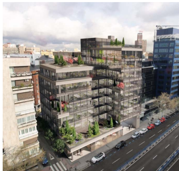
Recreación de la fachada de The Window Building , donde pueden identificarse las terrazas con vegetación vertical y el volumen descompuesto de la edificación. Si el peatón levanta la mirada se encuentra con terrazas ajardinadas con árboles que conforman un bosque vertical. Fuente de la imagen: Ortiz León Architects, 2018.
