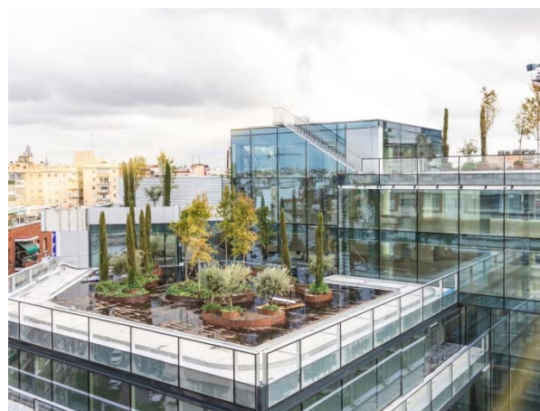
Detalle de la vegetación que puebla algunas de las cubiertas de The Window Building. Fuente de la imagen: Ortiz León Architects, 2018.
